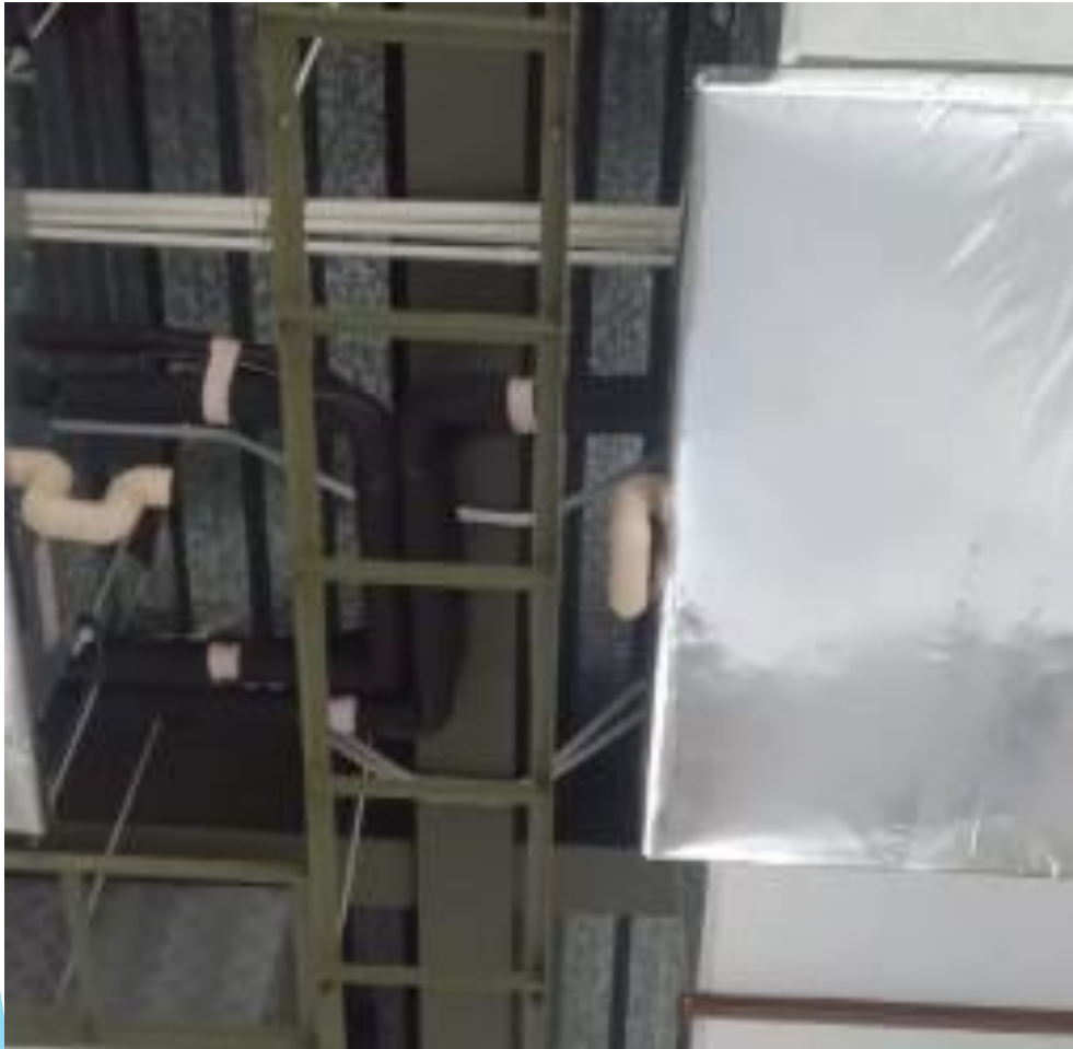
U TRAP PEMBUANGAN AIR AC
